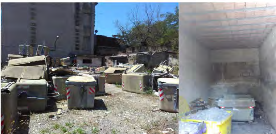
Figura 3 Piazzale ed interno dell'ex rimessa degli autobus
